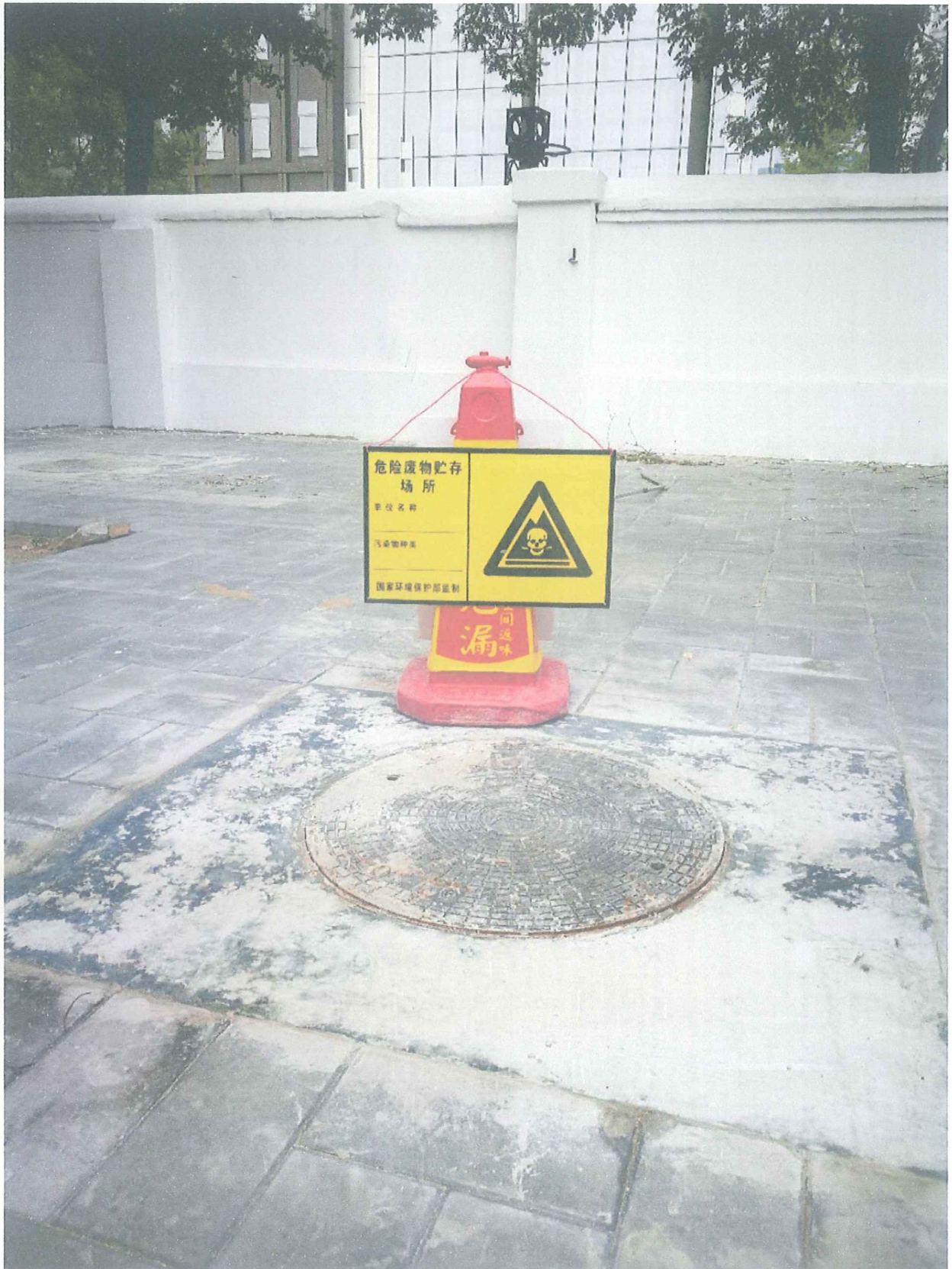
废污泥暂存池
