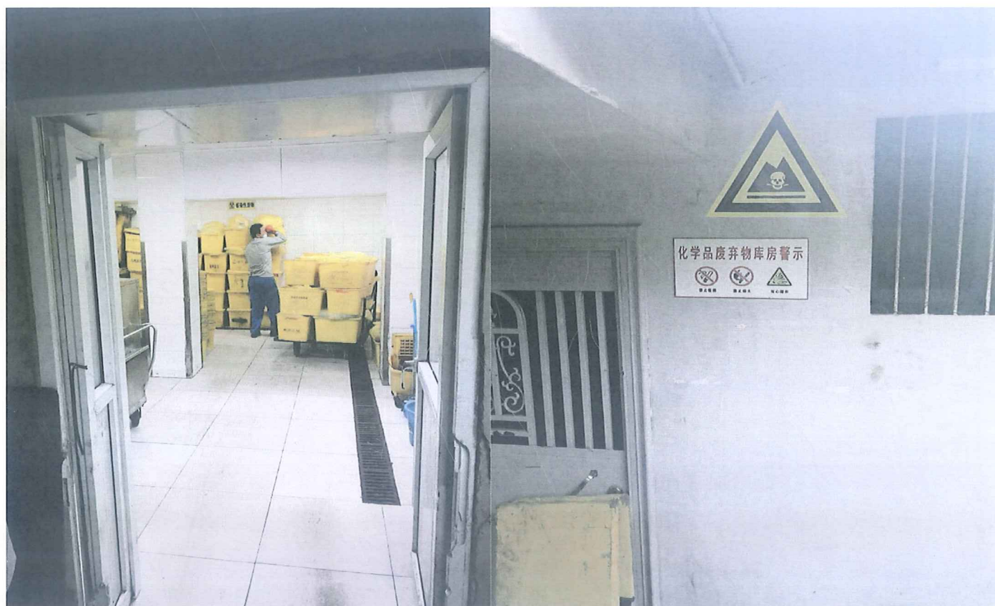
危废暂存间 图 4-2
